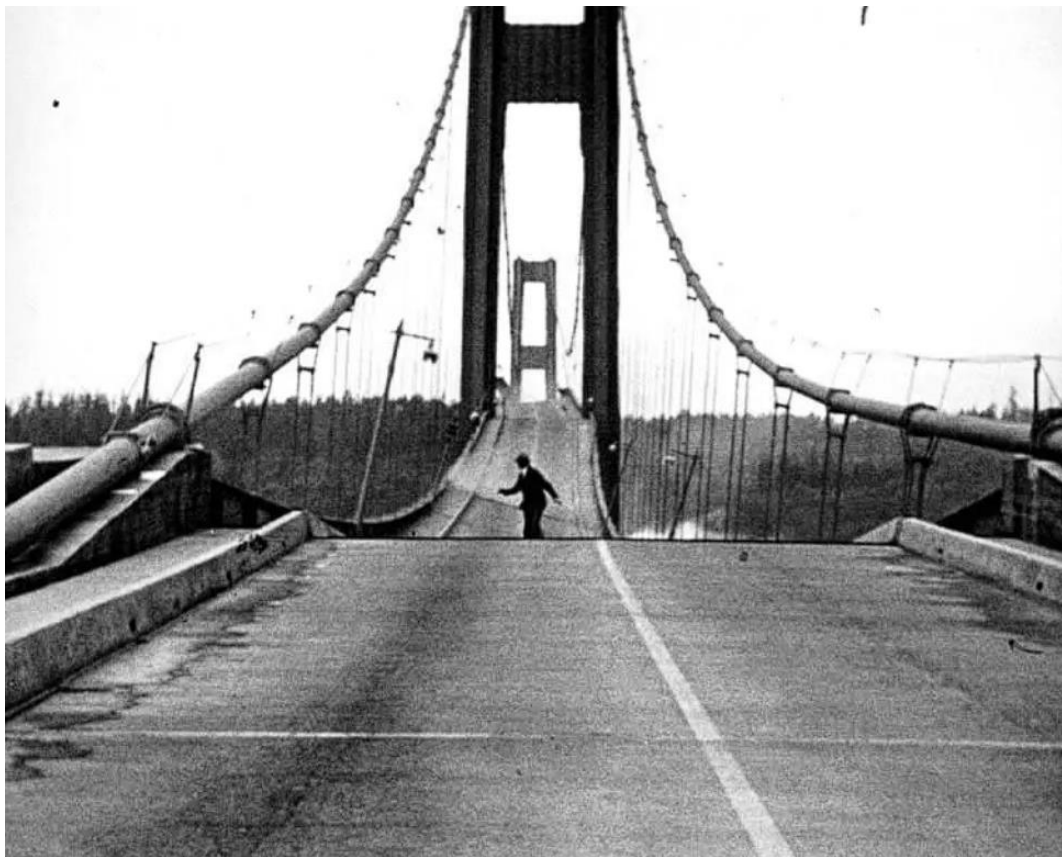
Slika 2.3 Urušavanje Tacoma Narrows mosta zbog rezonancije [2]
