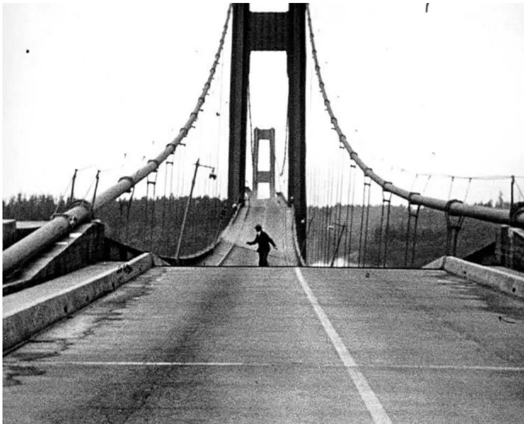
Slika 2.3 Urušavanje Tacoma Narrows mosta zbog rezonancije [2]
