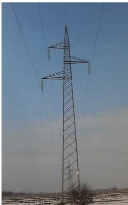
Slika 2.2. Nadzemni čelično-rešetkasti stup[1]
