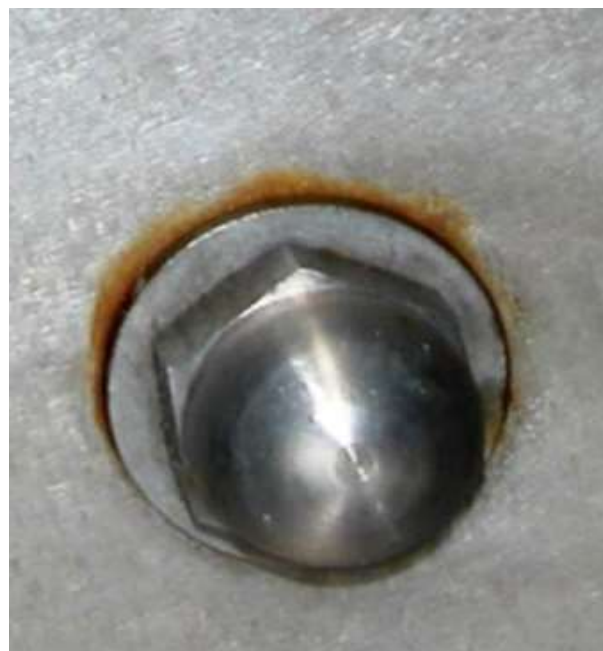
Slika 3.7 Primjer korozije u procjepu [9]
